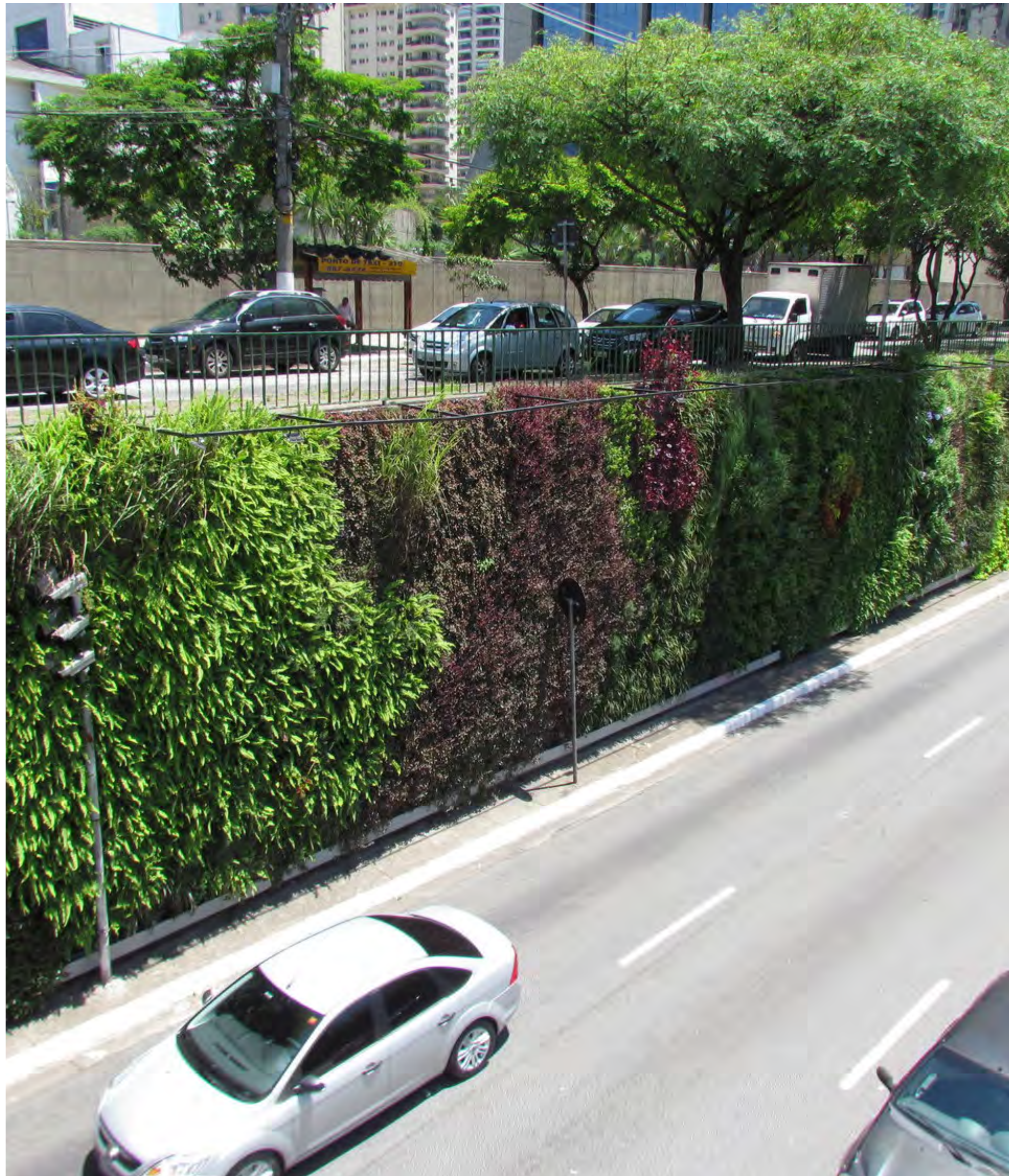
Muro verde vertical, Avenida 23 de maio - SP
